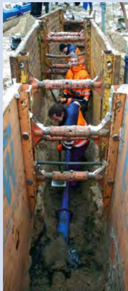
**Keine leichte Aufgabe: Bei Minusgraden und laufendem Bahnbetrieb wurde die defekte Trinkwasserleitung in Woltersdorf erneuert.**
